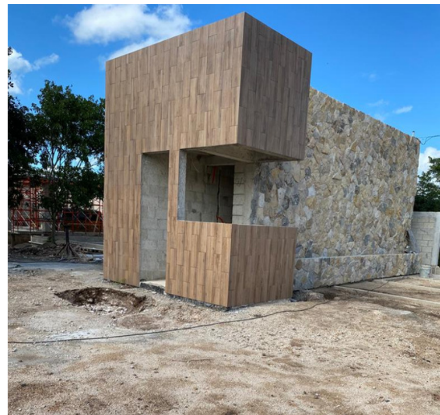
Caseta de seguridad
